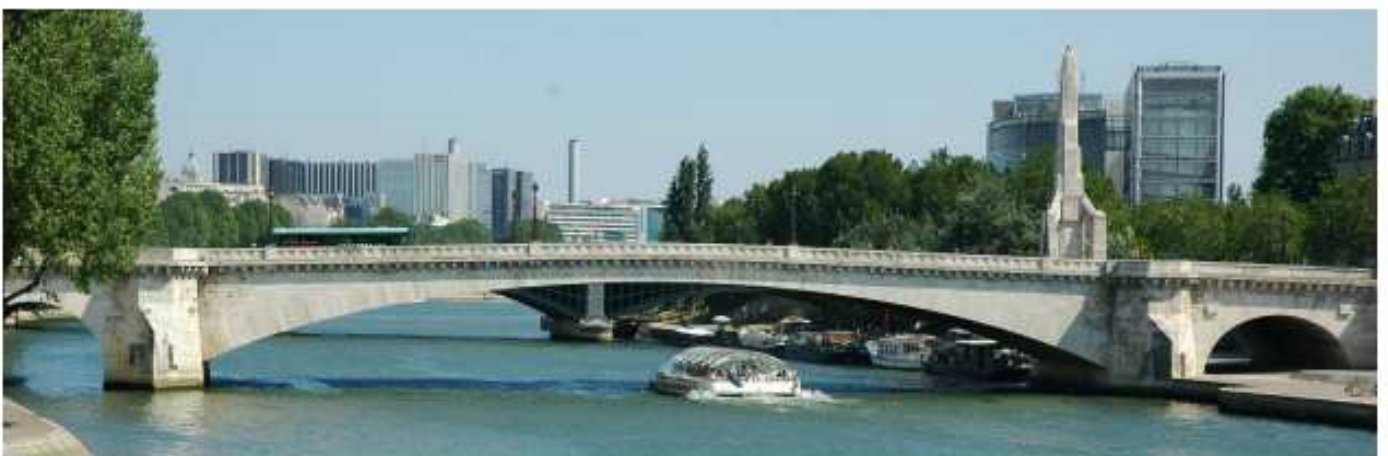
Pont de la Tournelle (Paris), pont en arc encastré d'une longueur totale de 120 m , début de la construction en 1928 et inauguré en 1930.
