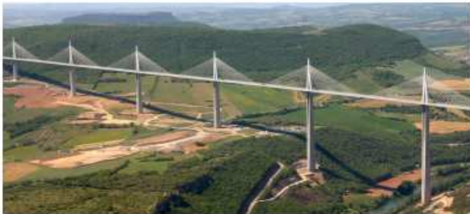
Viaduc de Millau, pont à haubans d'une longueur totale de 2460 m, avec des portées de 204 m et 342 m (2001-2004).
