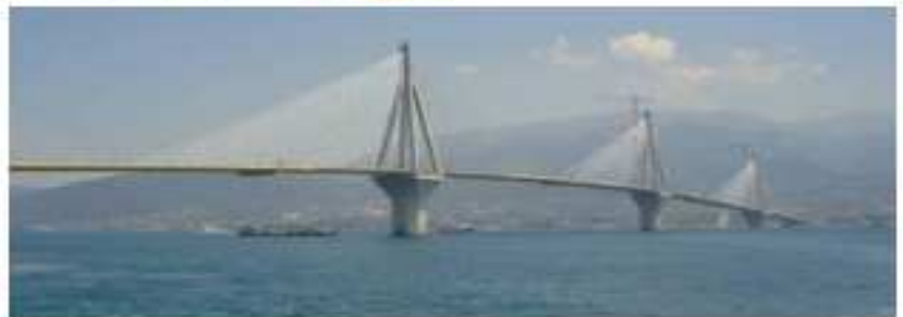
Pont de Rion-Antirion en Grèce, mis en service en 2004, d'une longueur totale de 2880 m, avec des portées de 286 m et 560 m. (1999-2004)
