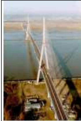
Pont de Normandie, pont à haubans d'une longueur totale de 2141 m, avec une portée centrale de 856 m (1989-1995).
