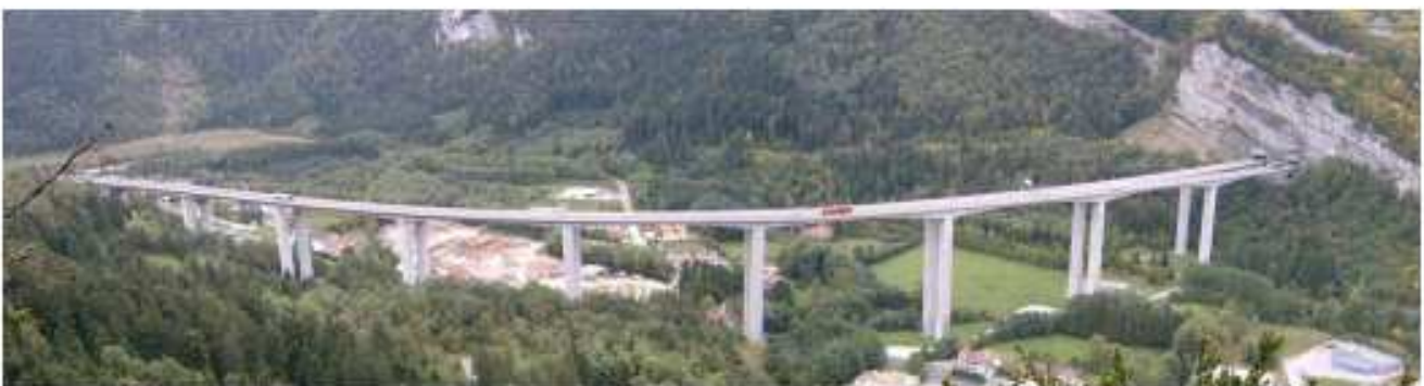
Viaduc de Nantua, ouvrage sur l'A40, inauguré en 1988.
