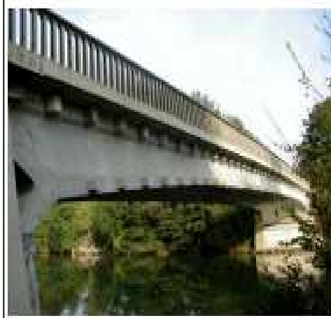
Pont de Luzancy sur la Marne, commencé en 1941 et inauguré en 1946. Pont à béquilles d'une portée de 55 m. C'est l'un des premiers grands ouvrages de Eugène Freyssinet en béton précontraint.
