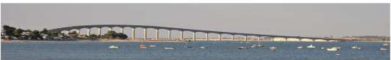
Pont de l'île de Ré, inauguré en 1988. La longueur totale de l'ouvrage est de 2927 m, avec des portées de 110 m.
